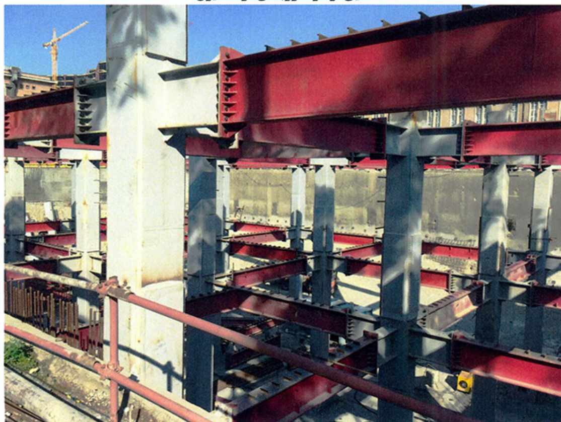
نمایی از نصب ستونها و تیرها
