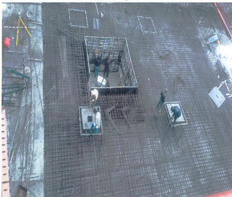
نمایی از آرماتوربندی فونداسیون
